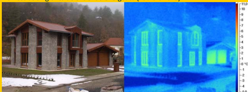
Edificación pasiva: Casa Arias en Roncal (Navarra). Temperatura media de fachada -0,5°C. Termografía realizada con temp. int. de 21°C. y en el exterior -1°C.
